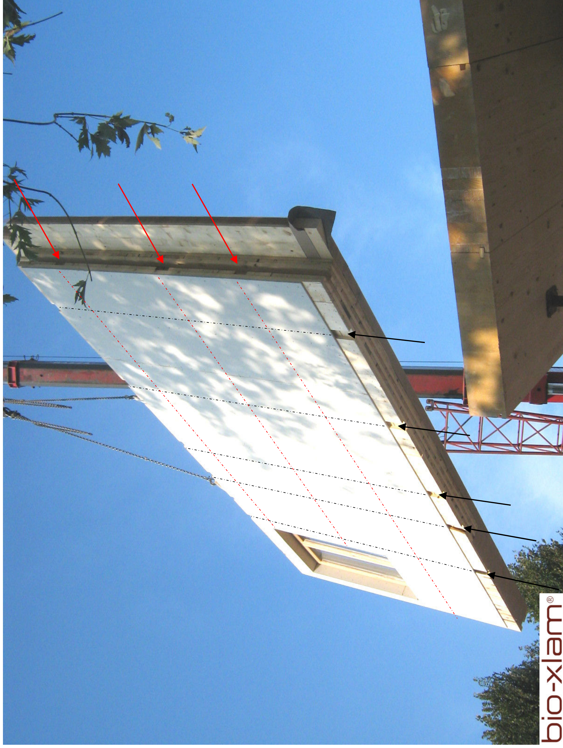
Kanäle für die Elektroverrohrung — Beispiel Wand mit vormontierter Gipsfaserplatte
